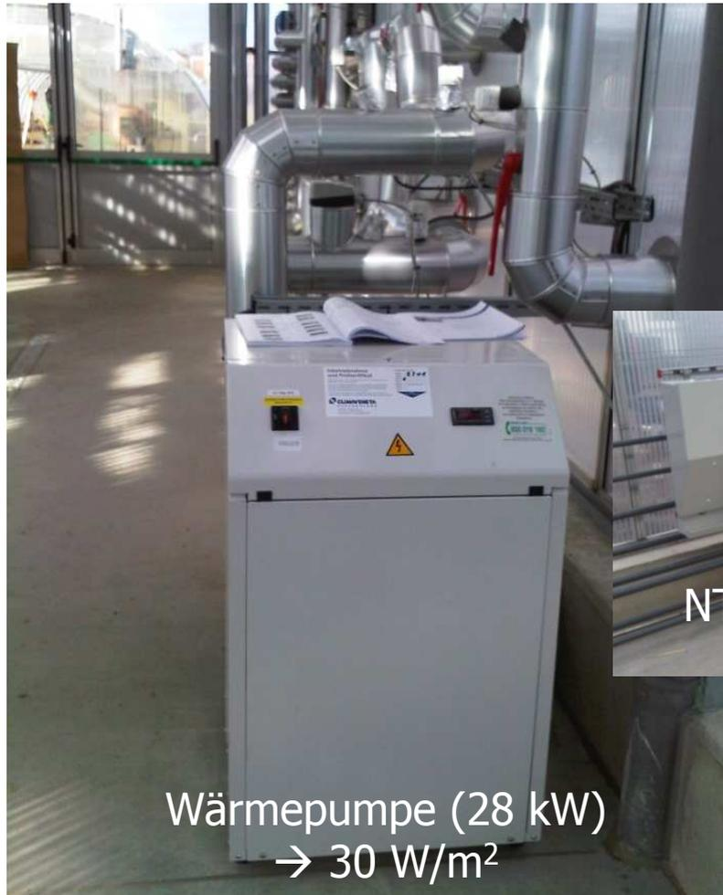
Wärmepumpe (28 kW)
