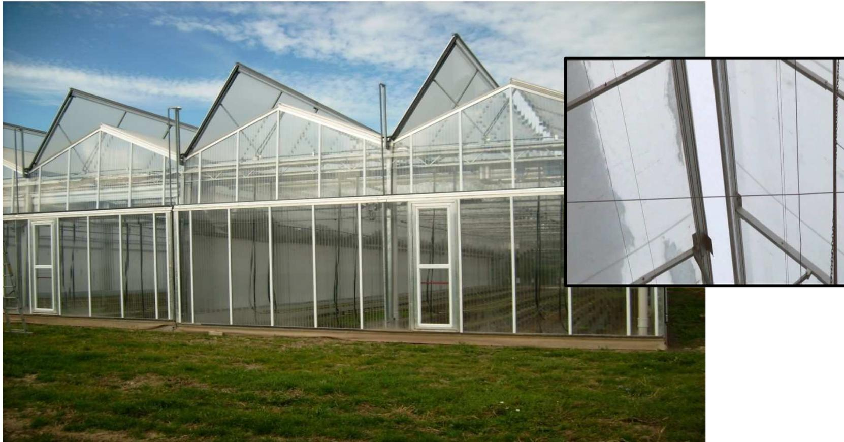
Jede Kappe hat eine durchgehende Lüftungsklappe mit Drehpunkt an der Rinne. Den Zugang zur Bodenbearbeitung ermöglichen die Hebe-/Senktore an den Giebeln.
